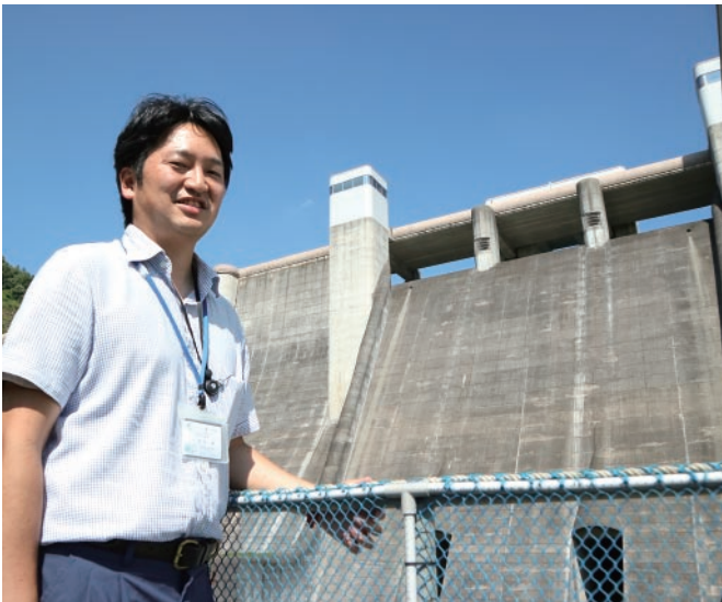
ダムをバックに笑顔の荒井さん。写真上部の三つの開口部が「天端側水路」の吐き口
